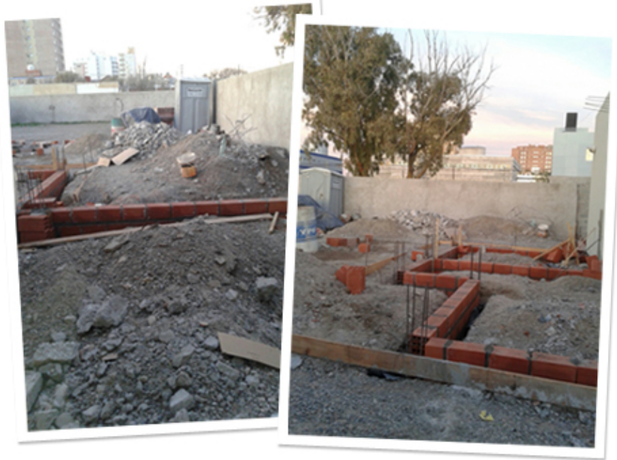
Comienzo de la obra
