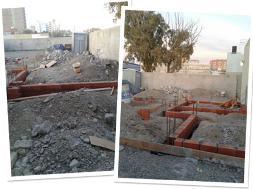
Comienzo de la obra
