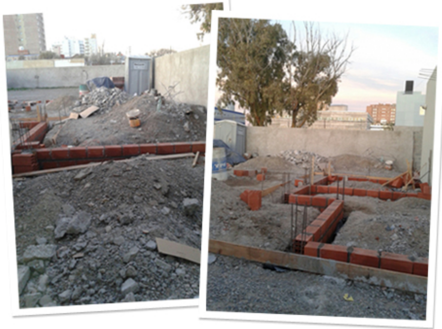
Comienzo de la obra
